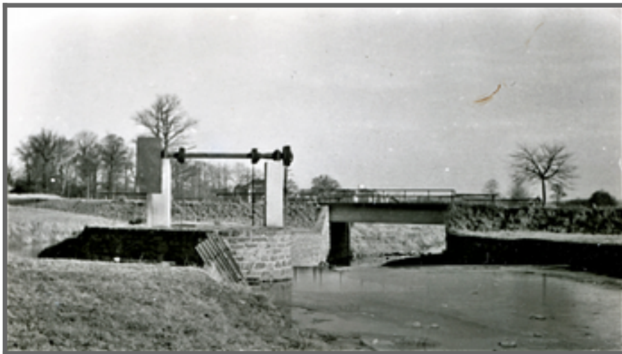
Abb. Das neue Wehr mit Stauklappe von 1950 oberhalb der 1940 errichteten Brücke
