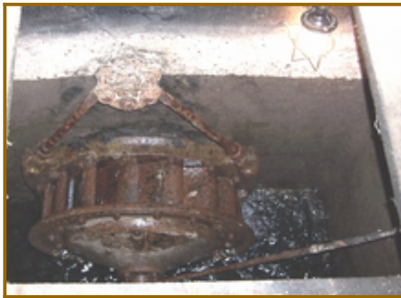
Abb. Die Francis-Turbine als das moderne "Wasserrad" der Herrenmühle
