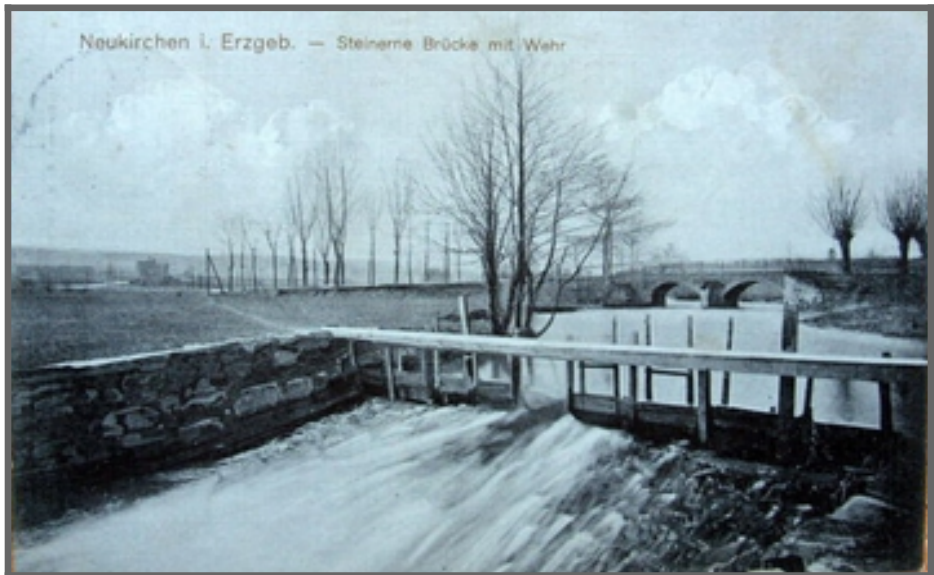
Abb. Die Steinerne Brücke, das alte Wehr und der Abgang Mühlgraben vor 1938
